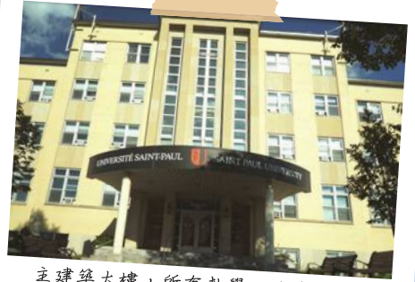
主建築大樓，所有教學、政業務皆在此大樓進行
