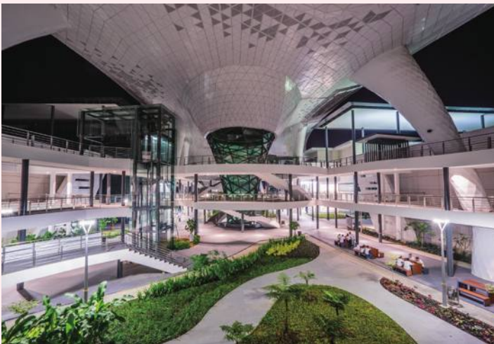
▲ UTS主建築內部
