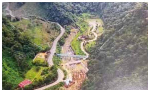
▲白冷圳抽藤坑倒虹吸工程。
