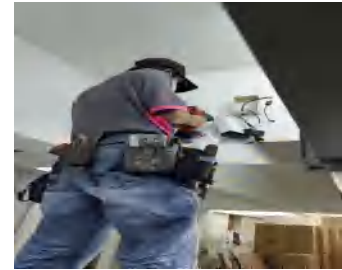
二教地下室設備更新
