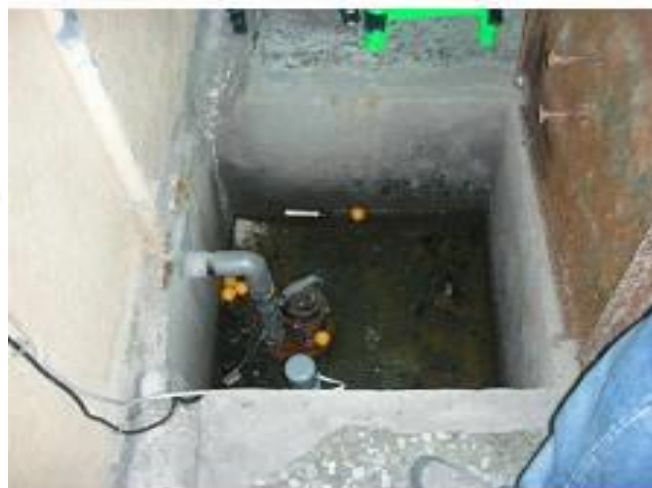
地下室集水槽
