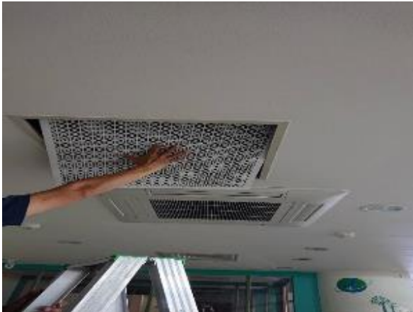
c.吊隱分離式濾網清洗（室內機在天花板內）
