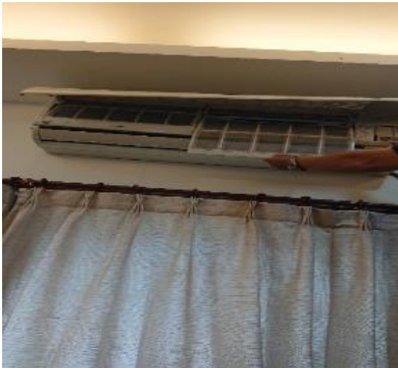
c.吊隱分離式濾網清洗（室內機在天花板內）
