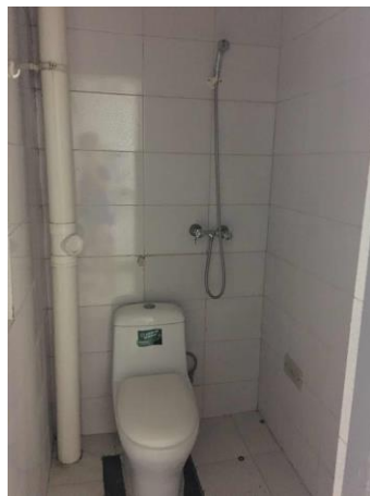
圖四、宿舍廁所
