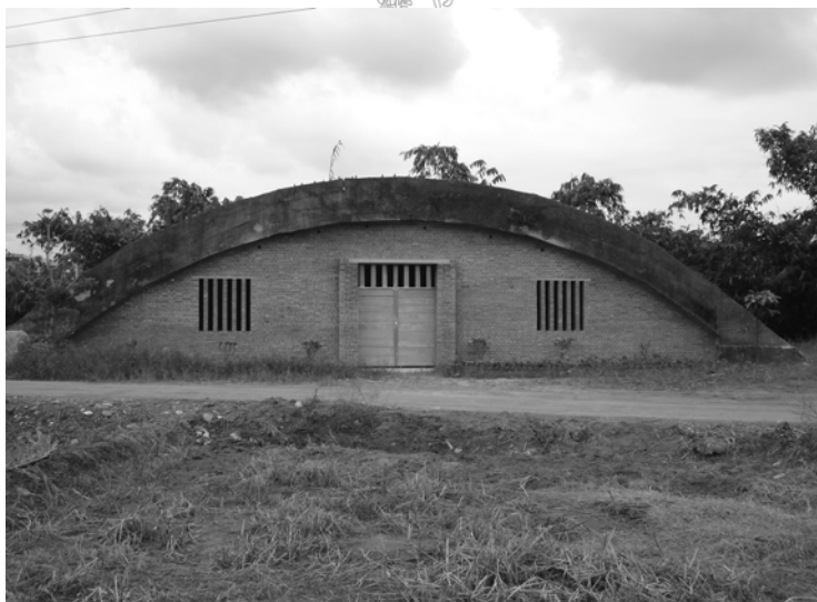
圖 3 宜蘭北機場附近的機堡，現為私人所有，雖以磚牆封住出入口，成為倉庫，但機堡原有外部樣貌可知。
