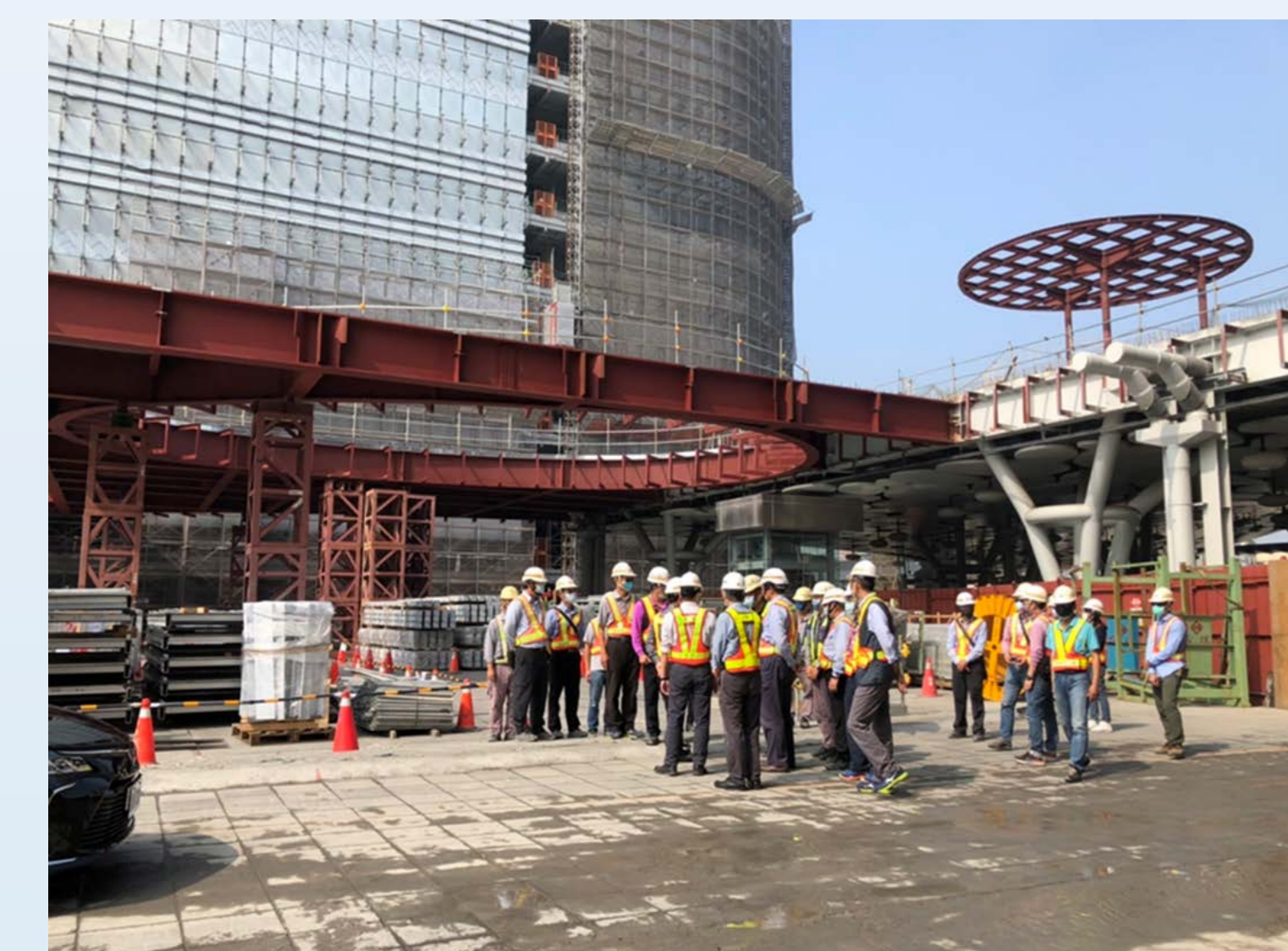
圖2:陪同業主巡視現場
