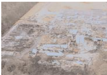
圖二 粉塵爆炸後的製藥廠。
