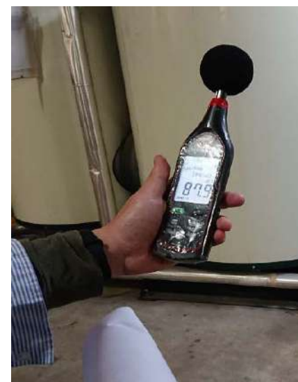
噪音計(鍋爐房)
