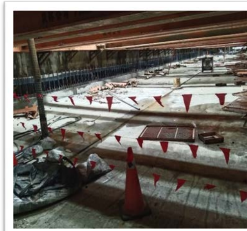
拆撐區範圍管制、淨空 (物體飛落危害)
