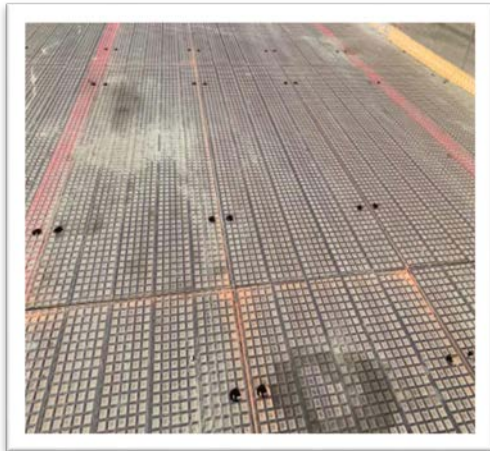
覆工板清理油漬 (工地環保)
