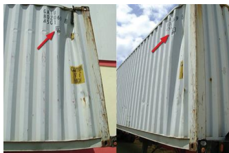
圖：結構損壞的聯運集裝箱
