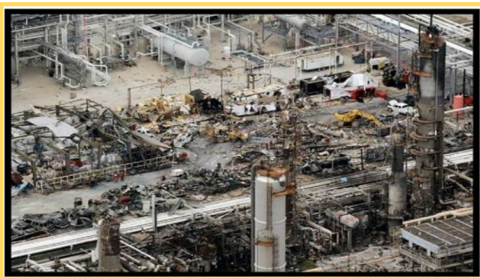
圖一 一家煉油廠發生爆炸，造成 15 人死亡，近 200 人受傷，空轉的柴油皮卡車是最有可能的點火源[2]。
