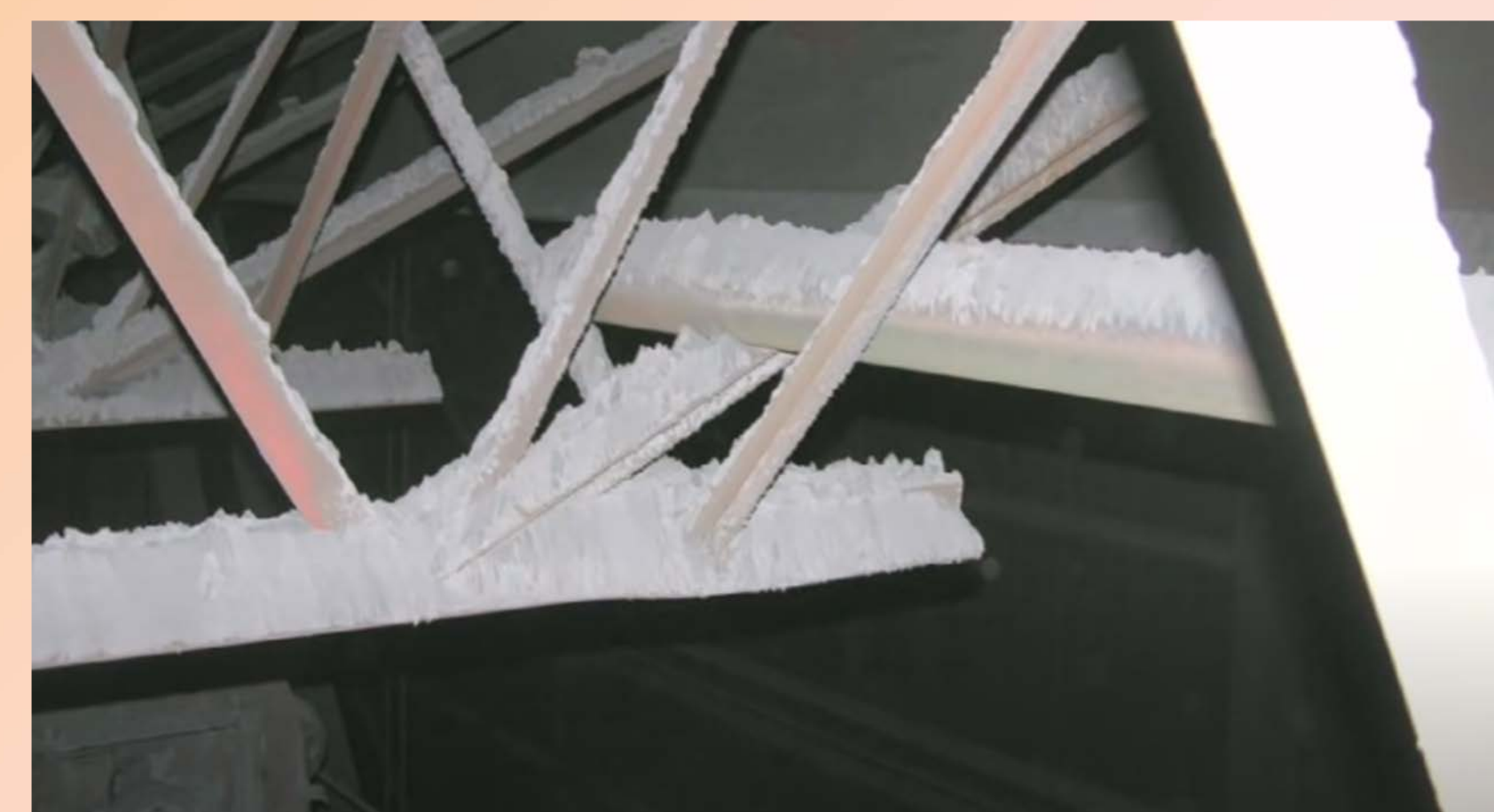
爆炸導致工廠大量堆積的鐵塵揚起震落
